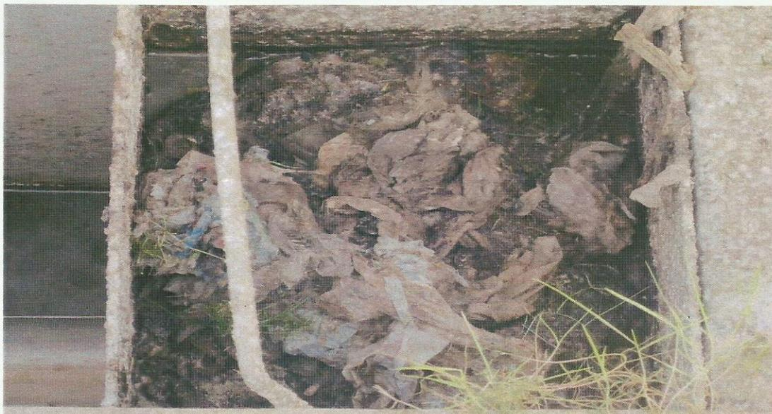
Et là, c'est facile à comprendre : si les ordures « balancées » dans les toilettes et non dans les poubelles, bouchent le passage au dégrilleur, les eaux usées montent et débordent. Où ça ?
